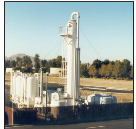
Este sistema de bombeo y tratamiento fue utilizado en la antigua base aérea Norton en el estado de California.
